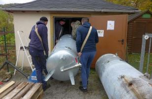
Wilschdorf den Einbau des neuen Kessels und die wasserseitige Anschlußinstallation durchführen. An einigen temperaturmäßig milderen Tagen im Dezember hat es Gfrd. Thomas noch geschafft, den Umbau der Elektroinstallation zu erledigen.
